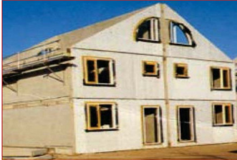
Figura 11. Vivienda construida con paredes prefabricadas de hormigón reciclado.
